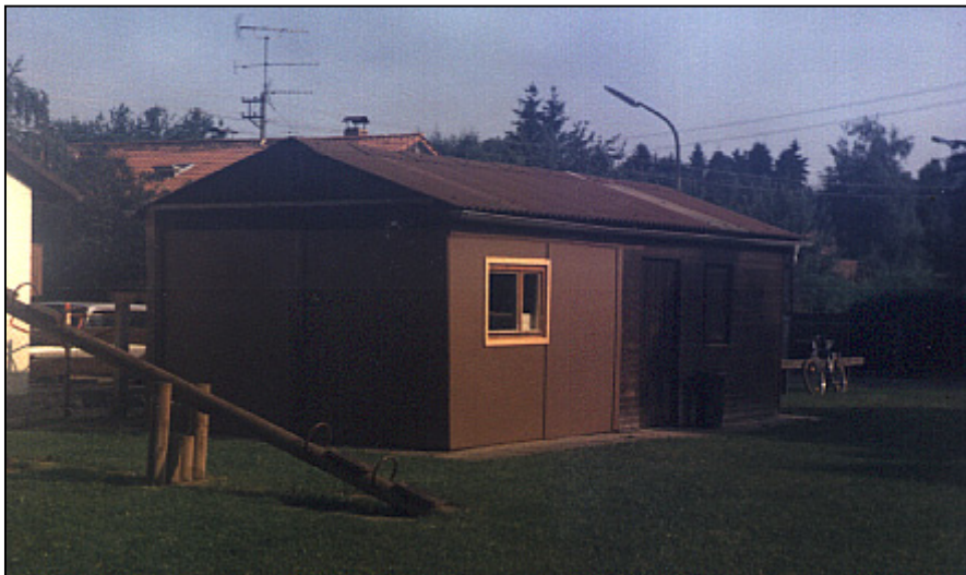
Mit einigen Reparaturkniffen und Farbe wurde der alte Geräteschuppen zusammengehalten. Jetzt wick sie der neuen Vereinshütte.
